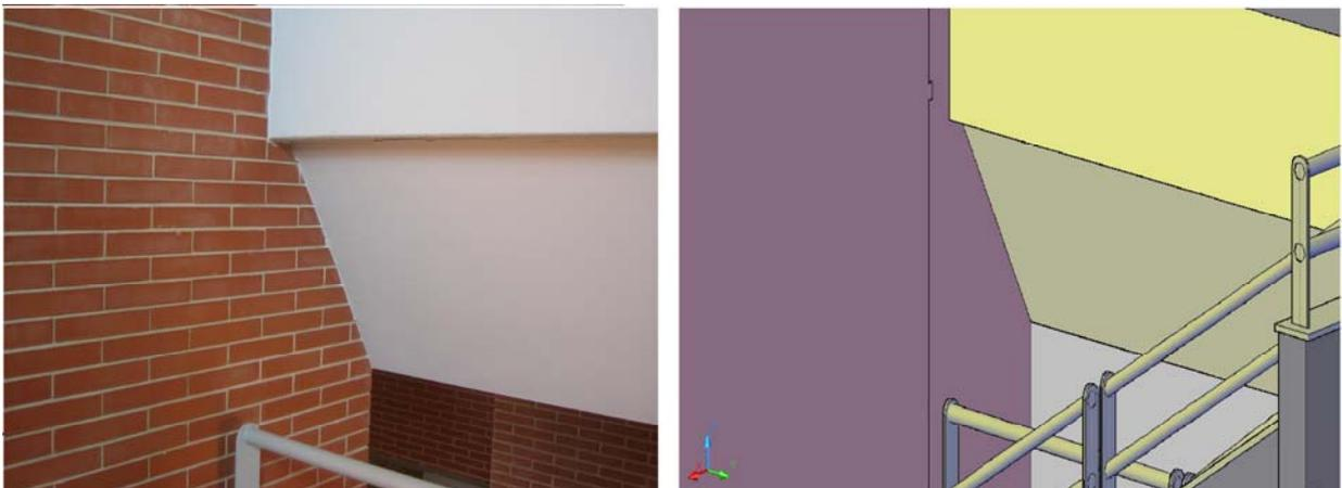
**Figura 2.2.3-03:** Techo de la escalera extremo SurOeste encajando en la esquina interior del edificio
