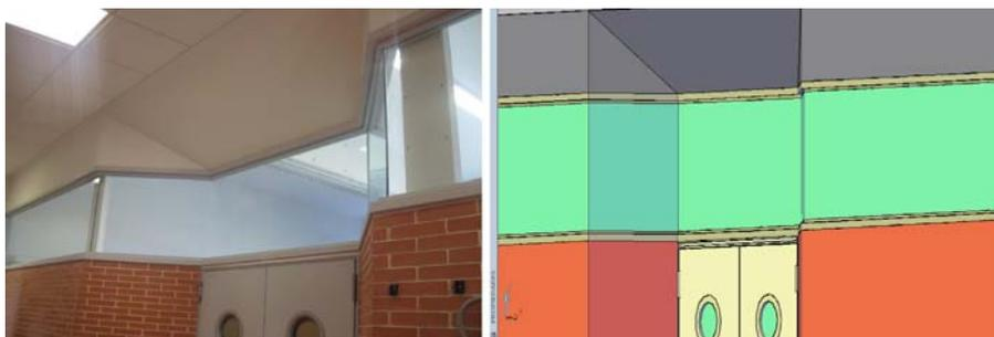
**Figura 2.2.2-04:** Adorno inclinado en las puertas de los laboratorios
