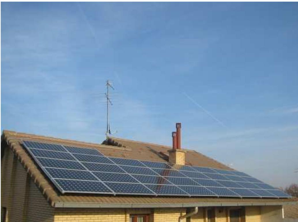
**Figura 9:** Instalación conectada a red en un tejado de vivienda privada
