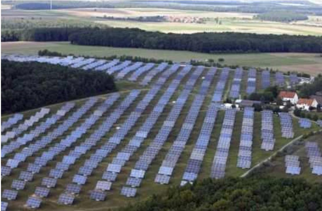
*Figura 11: Huerta solar con seguidores de dos ejes situado en la provincia de Murcia*
