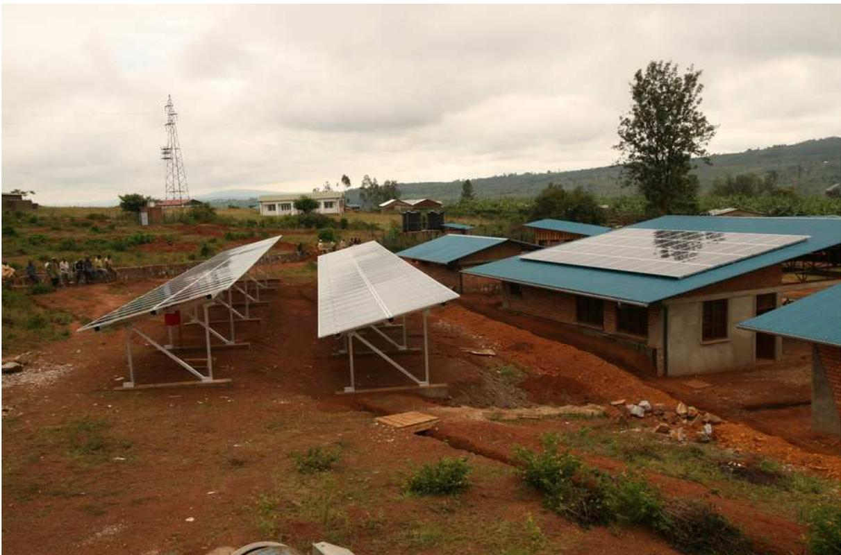
**Figura 6:** Sistema aislado de energía solar en Ruanda para abastecer una escuela rural
